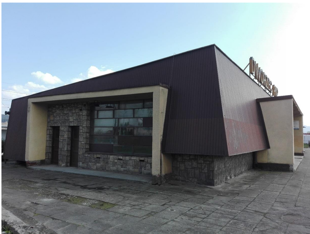
Fotografia 8. Niszczyjący budynek dworca w Starym Sączu.
