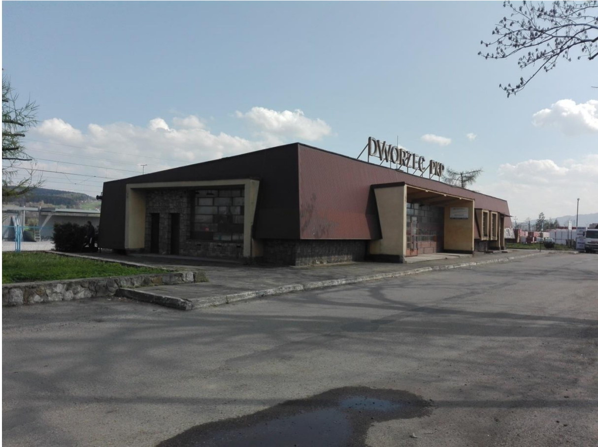
Fotografia 1. Budynek dworca kolejowego w Starym Sączu
