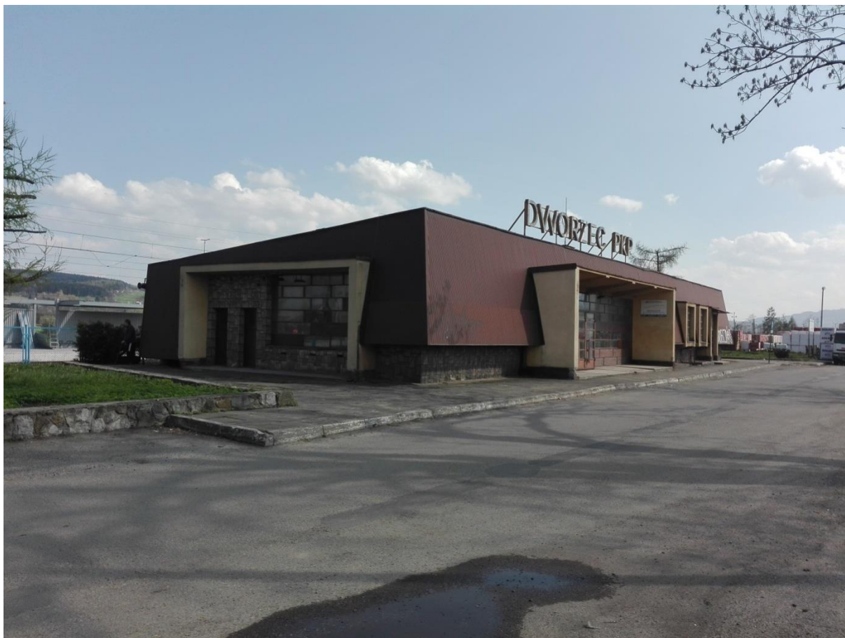
Fotografia 1. Budynek dworca kolejowego w Starym Sączu Źródło: Urząd Miasta i Gminy w Starym Sączu
