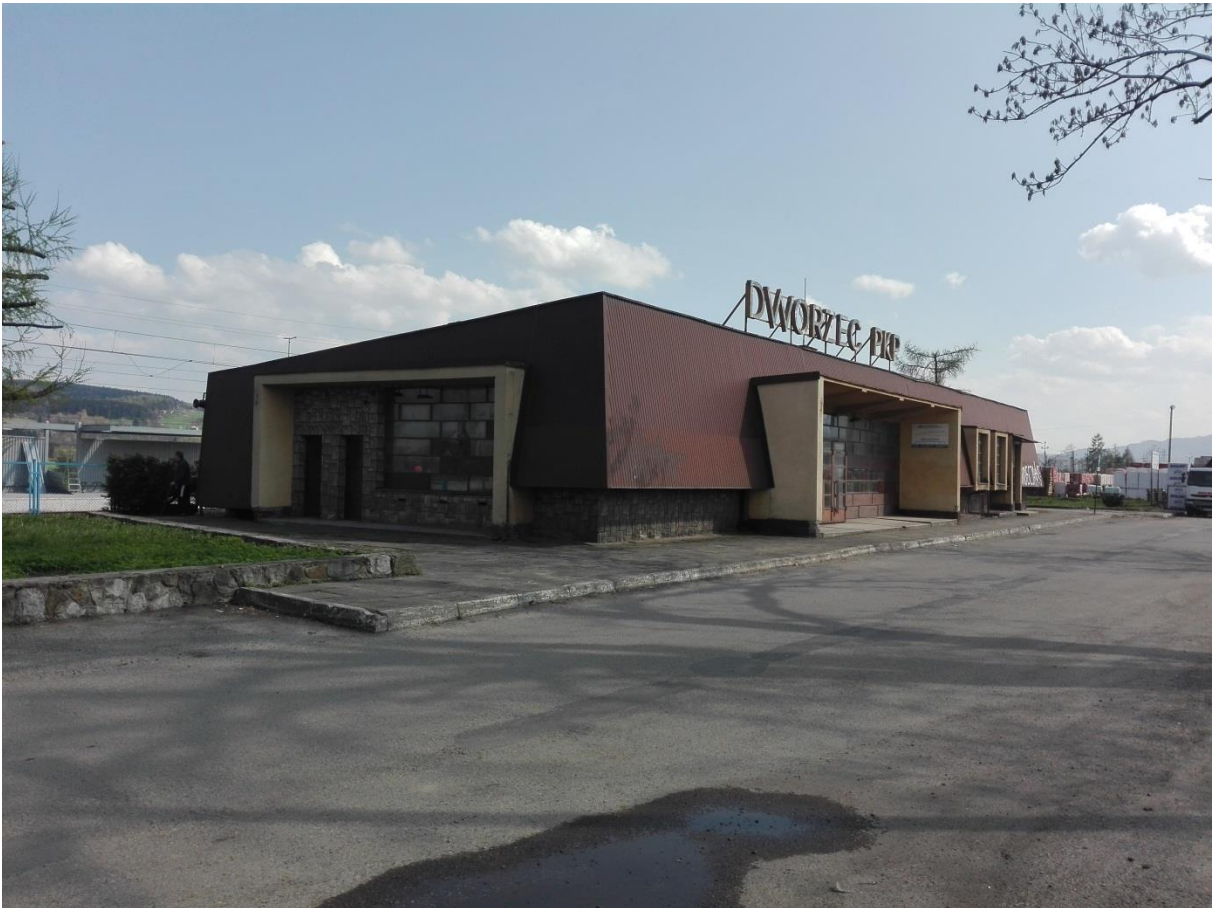
Fotografia 1. Budynek dworca kolejowego w Starym Sączu
