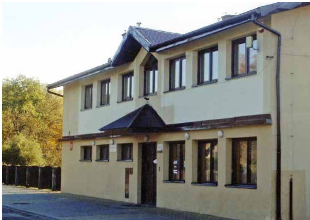
Budynek Wiejskiego Domu Kultury w Mostkach
