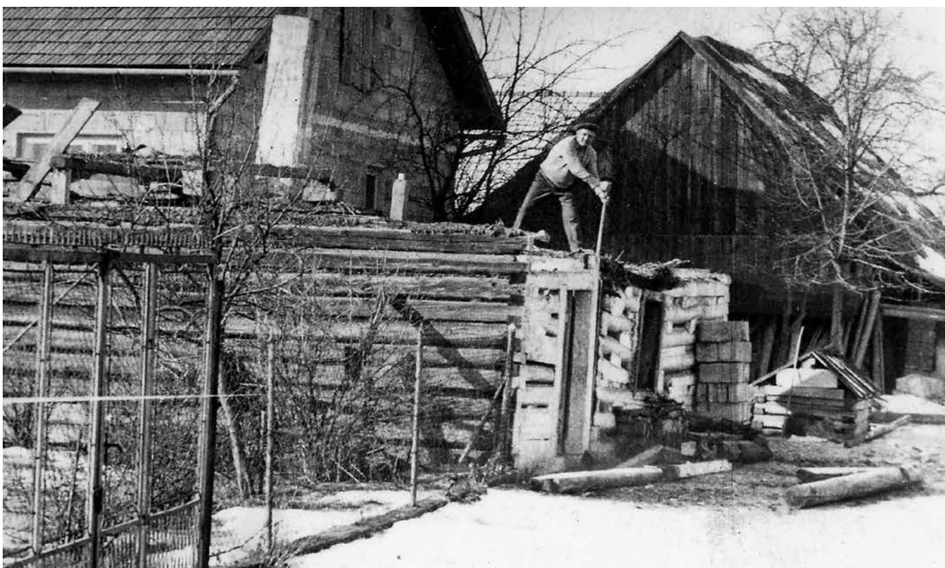
Chata pod strzechą w trakcie rozbiórki. Obecnie w tym miejscu znajduje się dom państwa Zielonków
