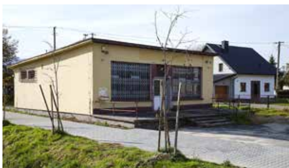
Budynek byłego sklepu SHP
